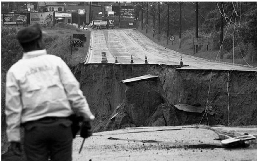
**Figura 4 – Erosão em rodovia causada por fortes chuvas [6]**
